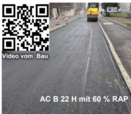
Fig. 7 Bau der HighRAP-Teststrecke in Uster
